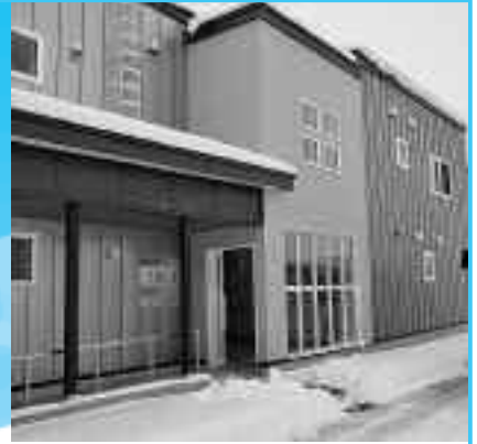
新しくなった、新町公営住宅
