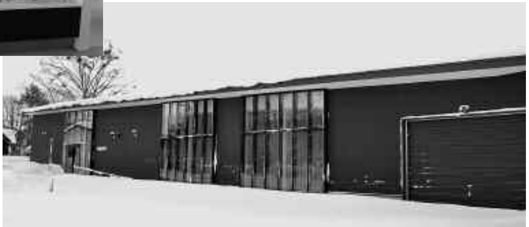
志比内地区交流センター（さくらプラザ）正面
