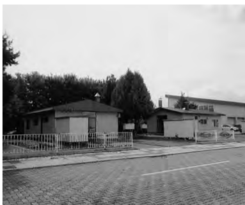
廃止予定の「東聖小学校」教頭住宅（写真右）
