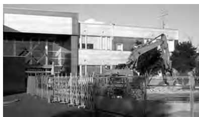
工事が始まったふれあい交流館
