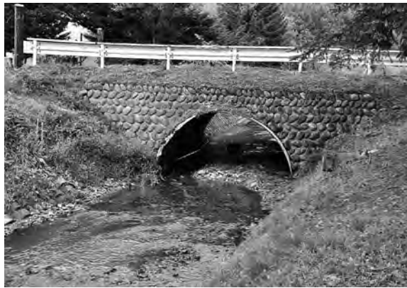
八千代公民館前の橋
