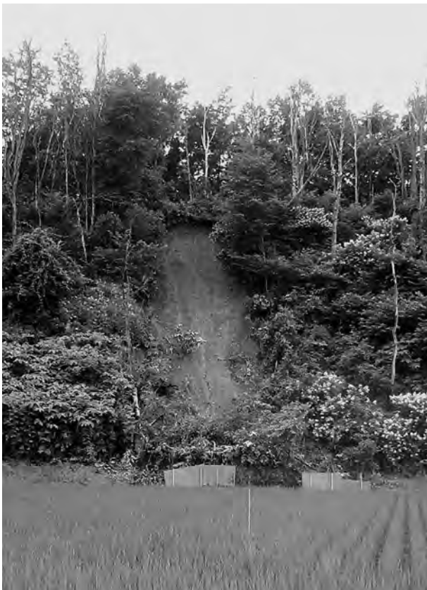
集中豪雨による崩落被害 (ポン川9号橋上流左岸側)
