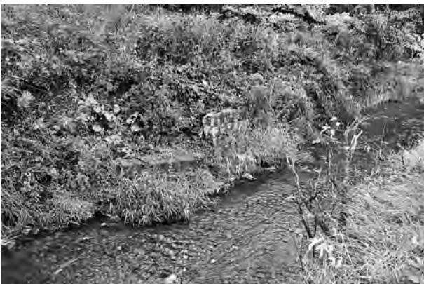
昨夏の豪雨被害（未補修）八千代川左岸
