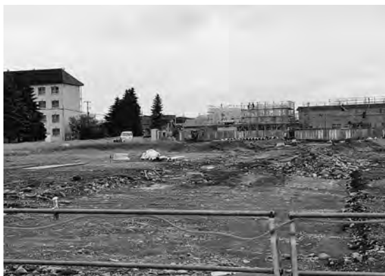
工事中の新町団地
