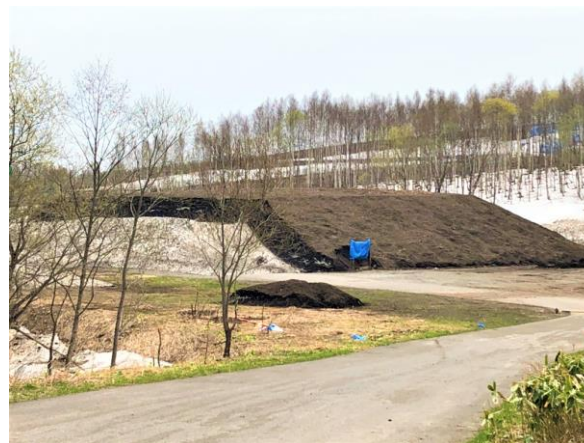
沼田式雪山センター（沼田町） バーク材で覆って雪を保管し （貯雪量5,000 t）、町内の施設 等に供給して冷房に活用
