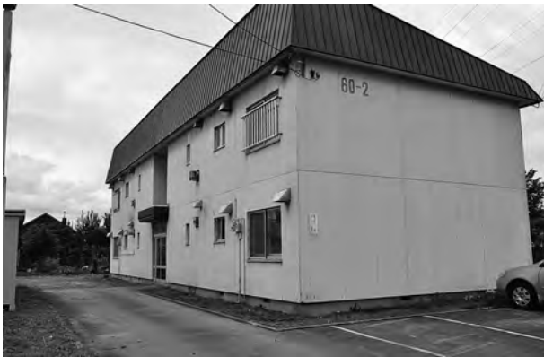
空室修繕予定の新町公住60-2
