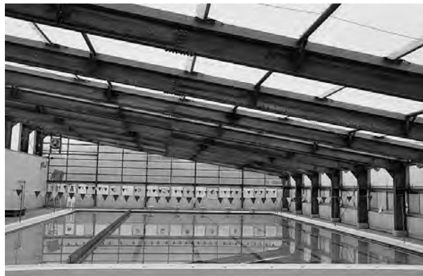
修繕が終了したふれあい交流館のプール
